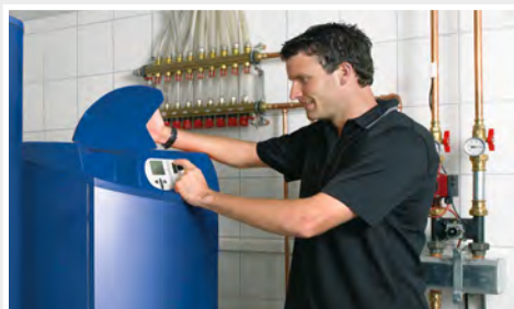
Mod. Heizungen stellen hohe Ansprüche an den Schornstein
