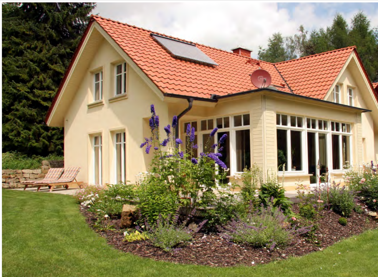
Mit dem ecobit Schornstein - Sanierungssystem ist Ihre Immobilie schnell auf dem neuesten Stand der Technik und von aussen sieht man fast nichts.
